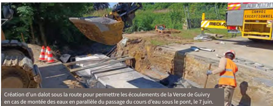
Création d'un dalot sous la route pour permettre les écoulements de la Verse de Guivry en cas de montée des eaux en parallèle du passage du cours d'eau sous le pont, le 7 juin.
