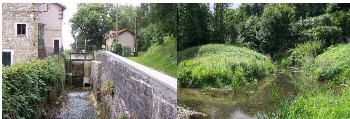
Photo 64 : Bras de restitution (eau non turbinée) vers la rivière
