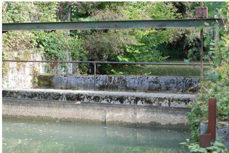
Photo 66 : Vanne fermée du moulin de la Forge
