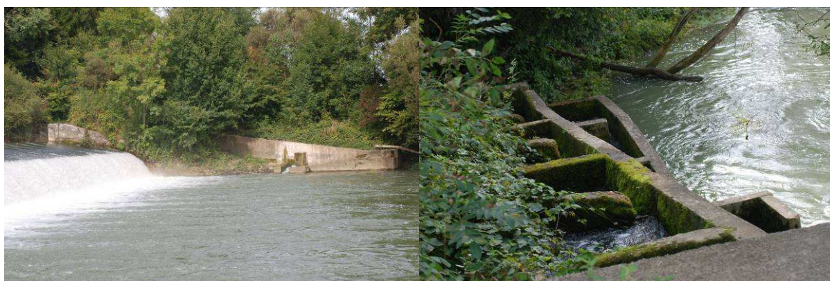
Photo 65 : Barrage de Montblainville et passe à poissons
