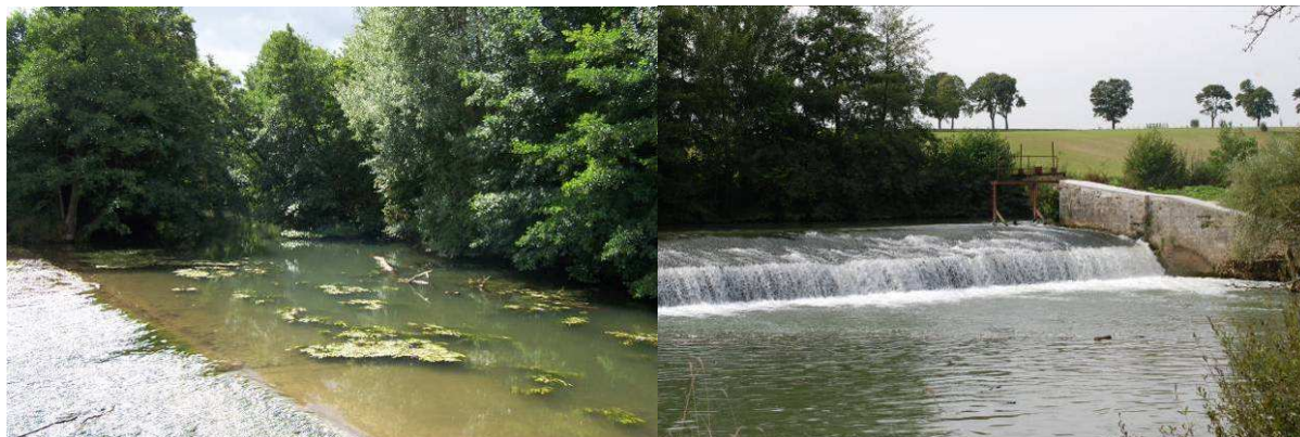
Photo 63 : Barrage de Varennes et vanne d'entrée du bief
