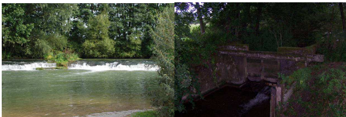
Photo 62 : Barrage de Boureuilles et vannes d'entrée du bief
