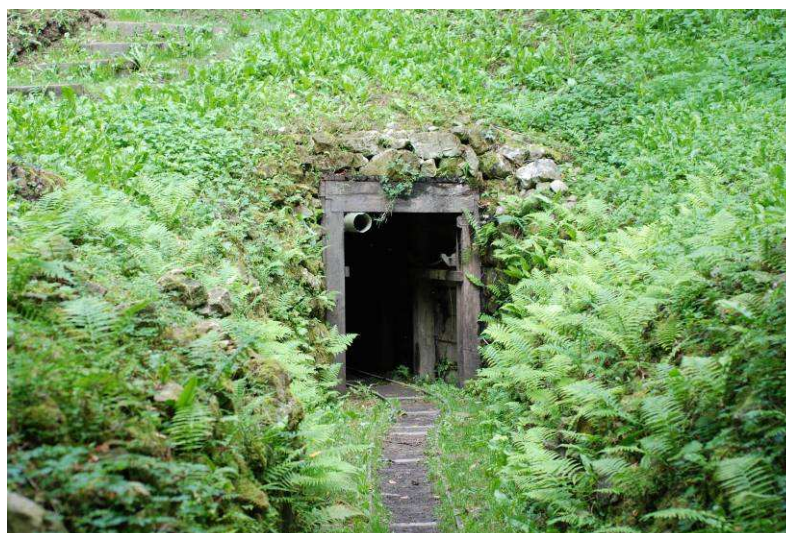
Photo 1 : Entrée d'une galerie sur la butte de Vauquois
