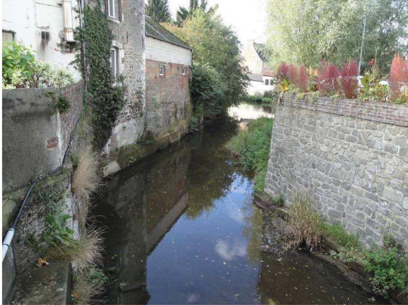
**Figure 31 : Berges maçonnées verticales au niveau de la dérivation du Gland en aval du seuil annexe**
