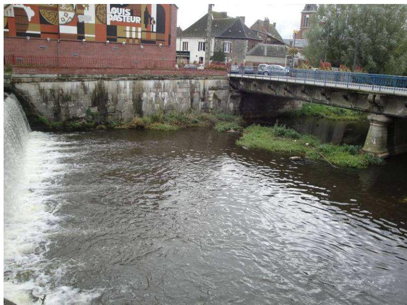
**Figure 36 : Vue de la fosse de dissipation et du contre-seuil en aval du seuil principal**
