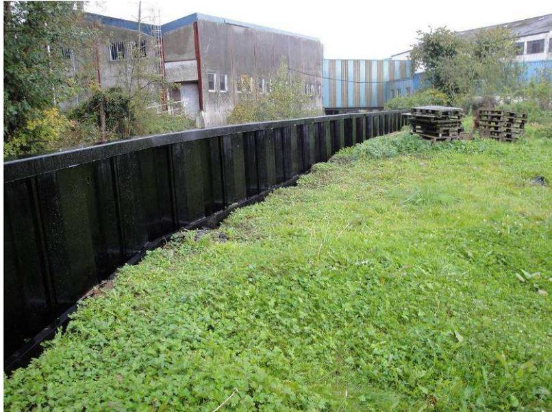
**Figure 33 : Présence d'un rideau de palplanches en rive gauche en aval de l'usine Vinolux**
