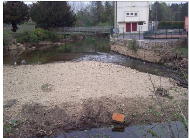
**Figure 35 : Illustration de la sédimentation en amont de l'ouvrage**
