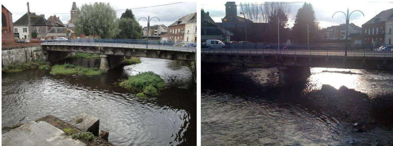
Figure 73 : Photos des atterrissements visibles en aval du seuil Pasteur sur le Gland
