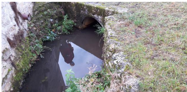
Vue en aval du carrefour
