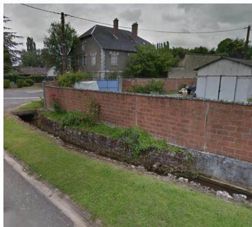
Figure 14 : Mur maçonné en rive droite du ru à conserver
