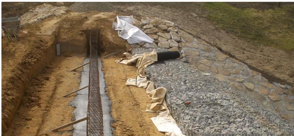
*Photo 1 : Exemple de réalisation d'une longrine béton pour seuil de digue (Données Antea Group)*
