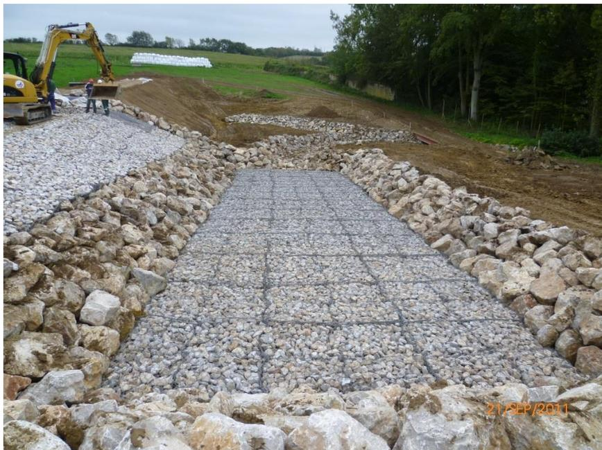
*Photo 3 : Illustration d'une fosse de dissipation*
