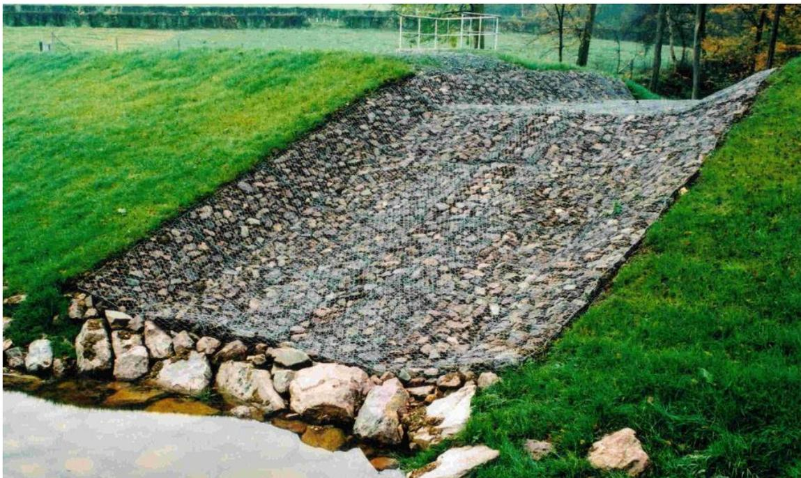
*Photo 2 : Illustration d'une surverse en matelas gabions*
