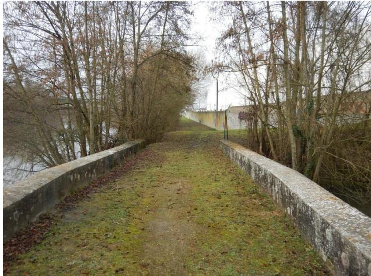
La photo suivante monte le début de la protection par mur béton. A droite de cette protection le site est protégé par un remblai en terre (qui rejoint le poste de crue de l'Aronde). Le point bas du portail d'accès est au même niveau que le mur béton de protection. Ce mur béton a été rehaussé par des agglos pour se conformer à la réglementation ICPE.
