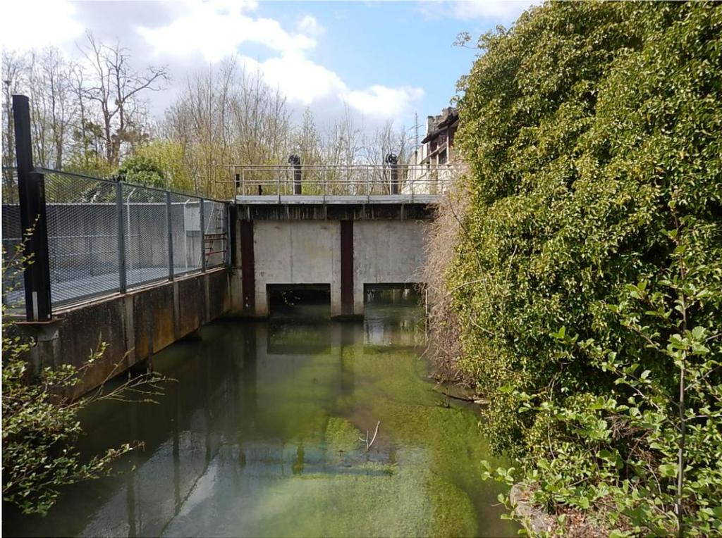
Figure 5-7 : Photo du poste de relevage au droit de l'Aronde, détail de vannes (Source : hydratec)
