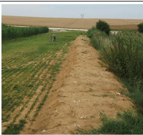
**Merlon.** Aussi appelé talus, cet ouvrage permet de jouer également un rôle de frein dans les ravines. Les billons placés sous les haies sont des aménagements à la structure similaire. Le rôle du merlon diffère de celui du gabion dans le fait qu'il soit imperméable, car il bénéficie d'un niveau de compactage important.
