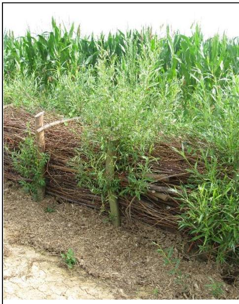
**Fascine vive.** L'intérêt d'une fascine est multiple : diminution des vitesses d'écoulement dans les thalwegs, diffusion de la lame d'eau, décantation des matières en suspension ... Ce dispositif est particulièrement efficace sur un axe de ruissellement concentré, comme une entrée charretière ou une ravine forestière bien incisée. C'est dans ce sens que la fascine constitue le pivot de ce projet d'aménagement, avec 9 ouvrages envisagés le plus souvent en cascades.
