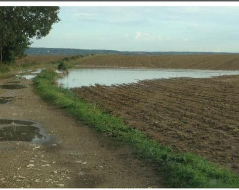
**Rehaussement de chemin.** Certains chemins agricoles traversent les thalwegs, et peuvent donc être remblayés pour créer une retenue temporaire dans les terrains agricoles. Le thalweg du Carrouge a déjà fait l'objet de ce type de remblai, et peut retenir des volumes importants, comme visible sur la photographie ci-contre.
