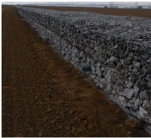
**Gabion.** Cet ouvrage joue un rôle similaire aux haies et fascines présentées précédemment. Ce muret, composé de pierres enrobées d'un grillage, n'est pas complètement imperméable, et un choix judicieux de porosité permet la filtration des boues et le ralentissement du ruissellement, dans des proportions plus importantes cependant qu'une fascine.
