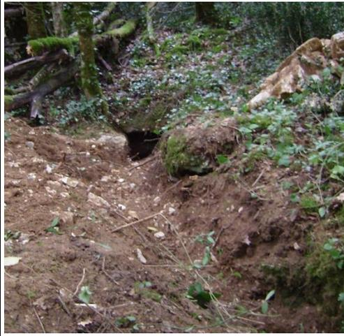
**Saignée.** Cette opération simple et peu coûteuse consiste à favoriser la dispersion de l'eau hors des axes d'écoulements, en creusant des petites rigoles sur les flancs et/ou en dégagant les végétaux constituant un frein. Les saignées, quand elles sont placées de façon répétée, sont notamment utiles pour disperser dans la végétation rase les écoulements fortement canalisés, dans les chemins agricoles et les sentes forestières peu incisées par exemple.
