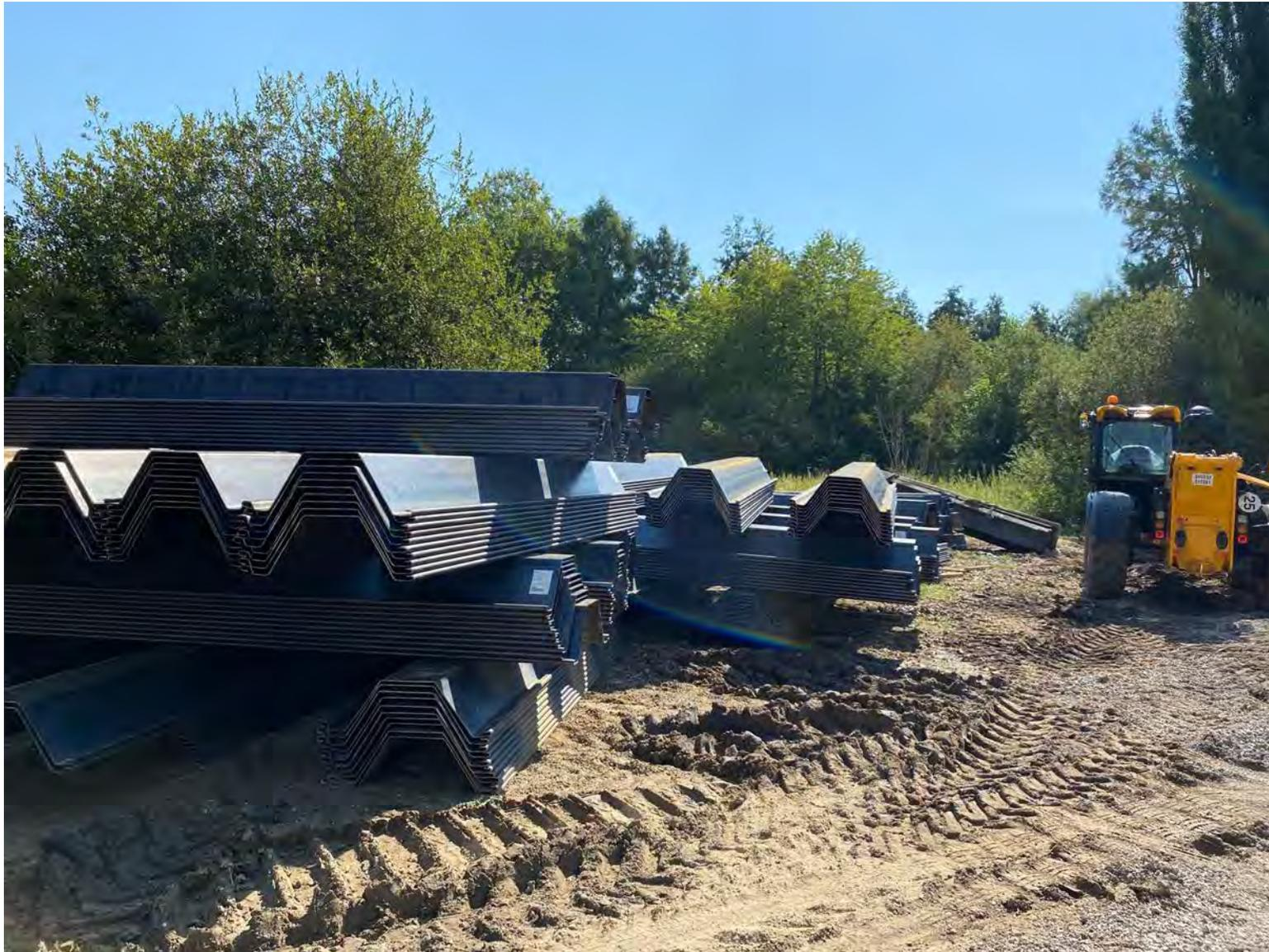
Les palplanches : pour l'étanchéité de la digue :
