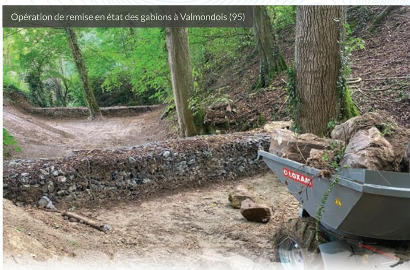
Au total, environ 100 m<sup>3</sup> de terre compactée ont été retirés en amont des ouvrages. Les sites ont fait l'objet d'une opération de débroussaillage. Les ravines ont été remises en état : la terre a été compactée, afin de rendre le sol homogène.
