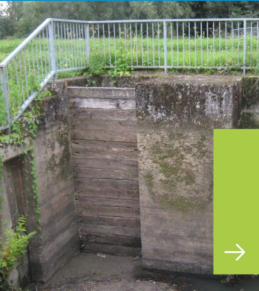
1. Gestion du siphon de Manicamp jusqu'au début des années 2000 : une vanne ouverte et une vanne fermée, l'une servant en cas de dysfonctionnement de l'autre
