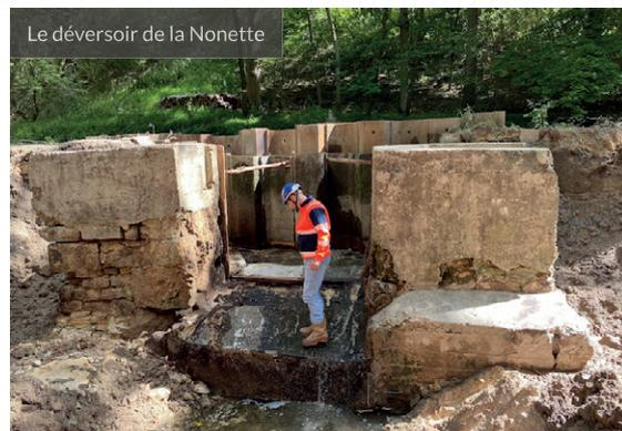
Le déversoir sera remis en eau à l'issue des travaux. Des enrochements seront installés dans l'axe d'écoulement vers le Saint-Urbain, qui conservera le même débit qu'avant travaux. ■
