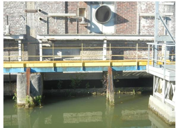
Photo 3 - photo 4 : Barrage de la grande Ventellerie – OA1 – Vannage latéral (2 vannes manœuvrables et 2 vannes fixes)
