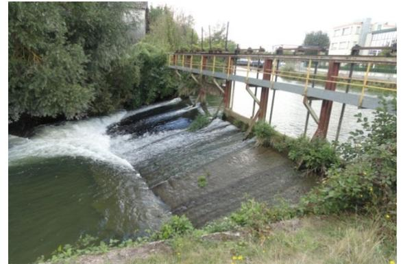
photo 6 : 3 vannes fermées et 3 vannes ouvertes
