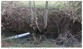
Figure 43 : Verse perchée : ouvrage pluvial à nu et en hauteur par rapport au fond
