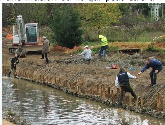
techniques végétales de protection de l'ensemble de la berge : ensemencement de plantes herbacées et plantations diverses, avec mise en place d'un géotextile biodégradable si nécessaire pour fixer la terre végétale avant l'installation de la végétation dans les zones les plus pentues ; bouturage d'arbres et arbustes ; lit de branches ; ...
