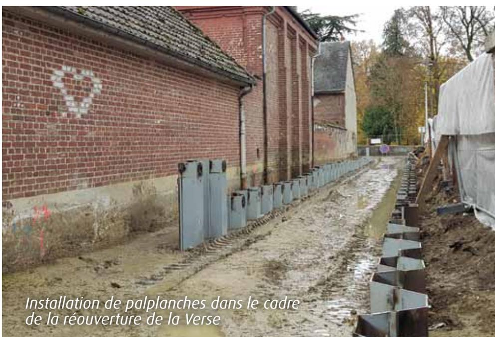
*Installation de palplanches dans le cadre de la réouverture de la Verse*
