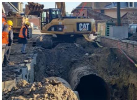
planches posées, la terre est creusée et la buse dans laquelle s'écoulait la Verse est retirée. La rivière s'écoule ainsi dans un nouveau lit, à ciel ouvert.
