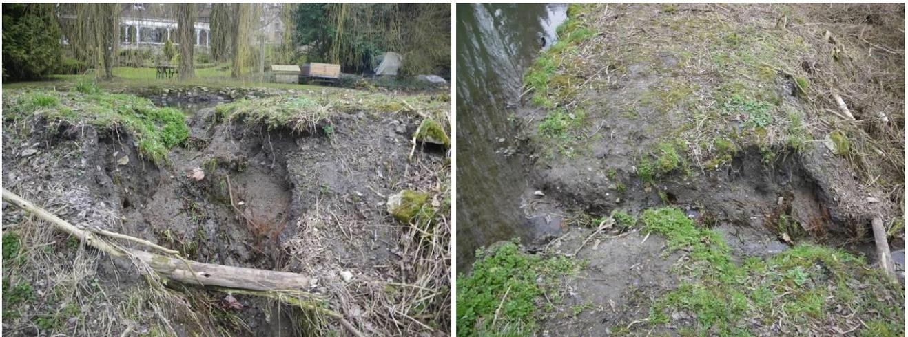
Figure 27 : Photos des dommages engendrés par la surverse sur la digue de Villemétrie (source : SISN, mars 2013)
