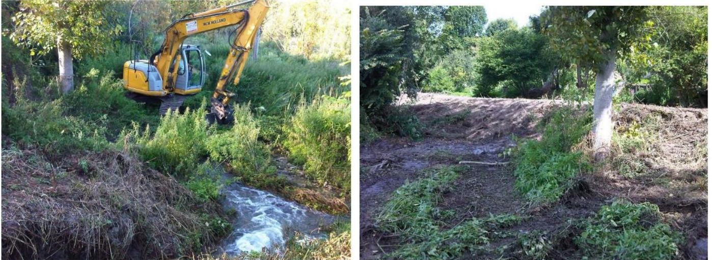
Figure 26 : Photo des travaux sur la fuite de la digue de Villemétrie (source : SISN, août 2012)
