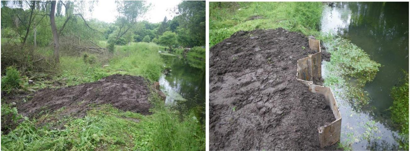
Figure 28 : Photos suite aux travaux de restauration sur la digue de Villemétrie (source : SISN, juin 2013)
